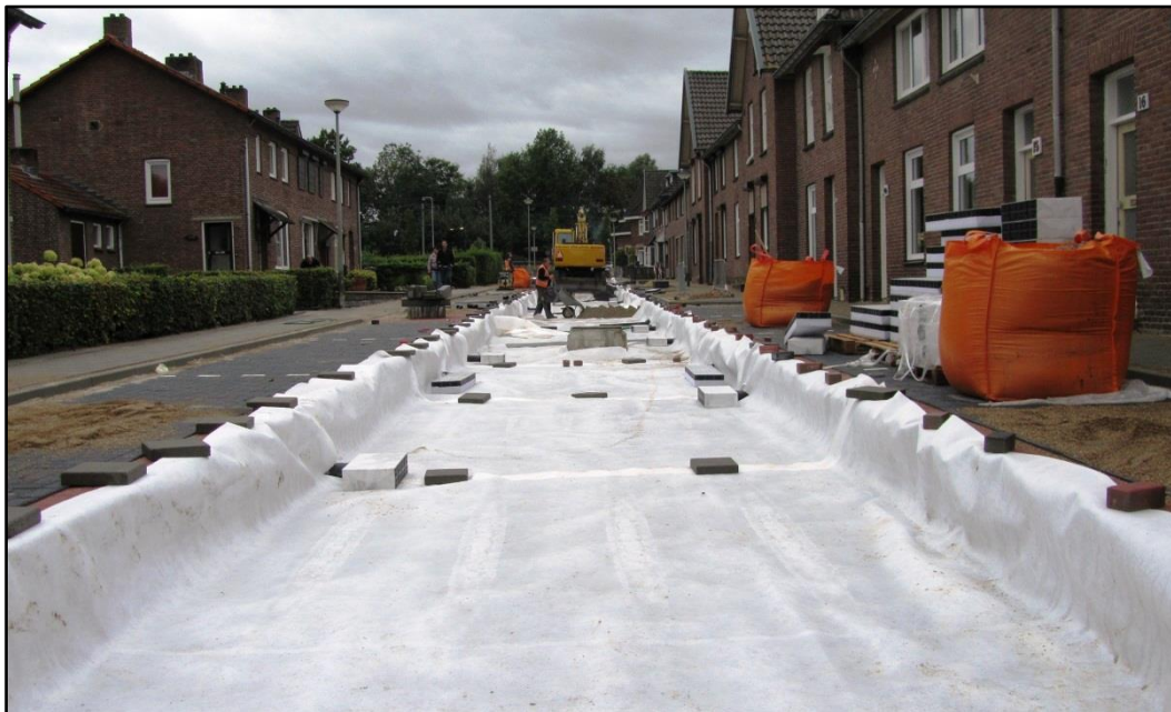
Aquaflow: waterbergend cunet, inclusief aansluitingen voor WT kolken en daken van woningen.
