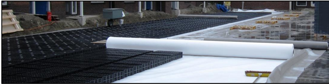
Aanbrengen Permavoid funderingsvervanger (75mm, 85mm of 150mm hoog) voor waterberging
