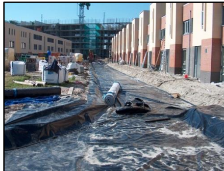
Aquaflow® als bergingssysteem, functioneert ook in slecht doorlatende grond.
