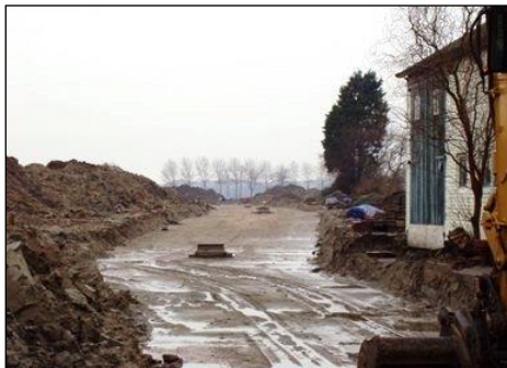
Hier is Aquaflow® aangelegd in een gebied met hoog grondwater
