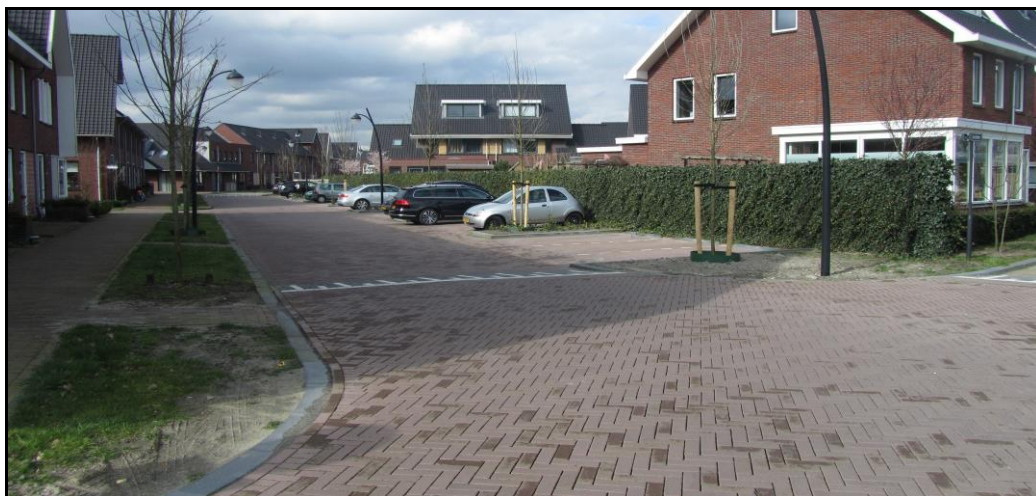
In een woonwijk wordt regenwater in de vlak uitgevoerde wegen opgevangen en geïnfilteerd.
