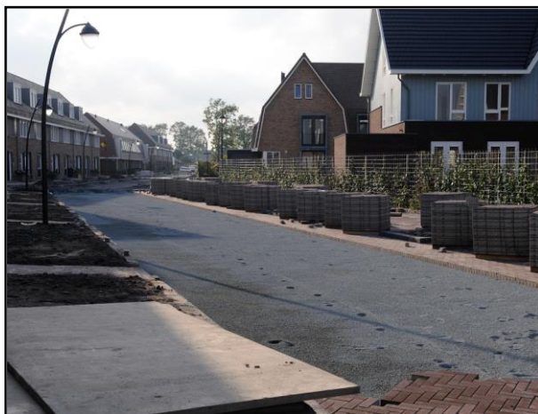
De vlakke wegen zijn opgebouwd met de waterbufferende fundatie (40% holle ruimte). Een HWA is niet aangelegd.
