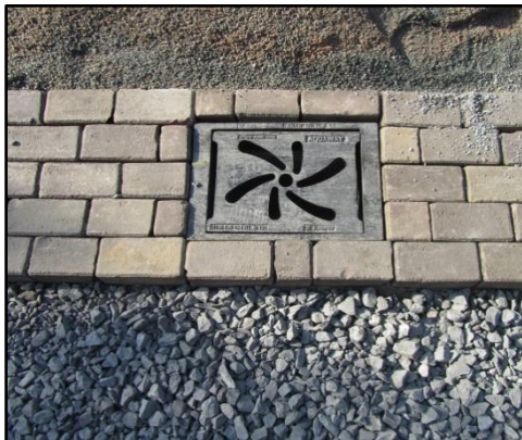
Hemelwater stroomt via WT kolken in het Aquaflow funderingspakket
