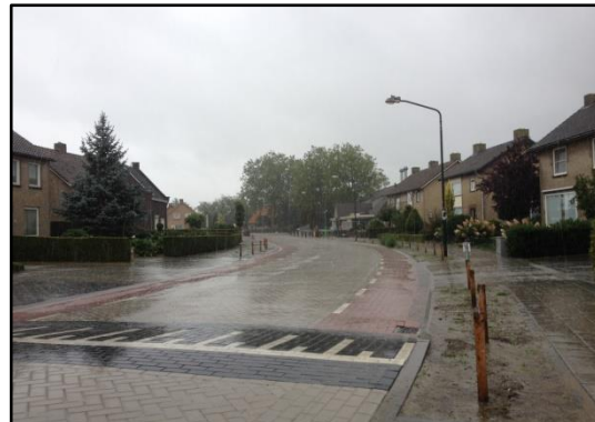
Onder elke m 2 verharding bevindt zich 140 liter berging. Afvoer hemelwater met WT kolken.
