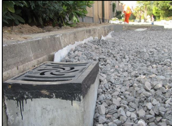
Hemelwater stroomt via WT kolken in het Aquaflow funderingspakket
