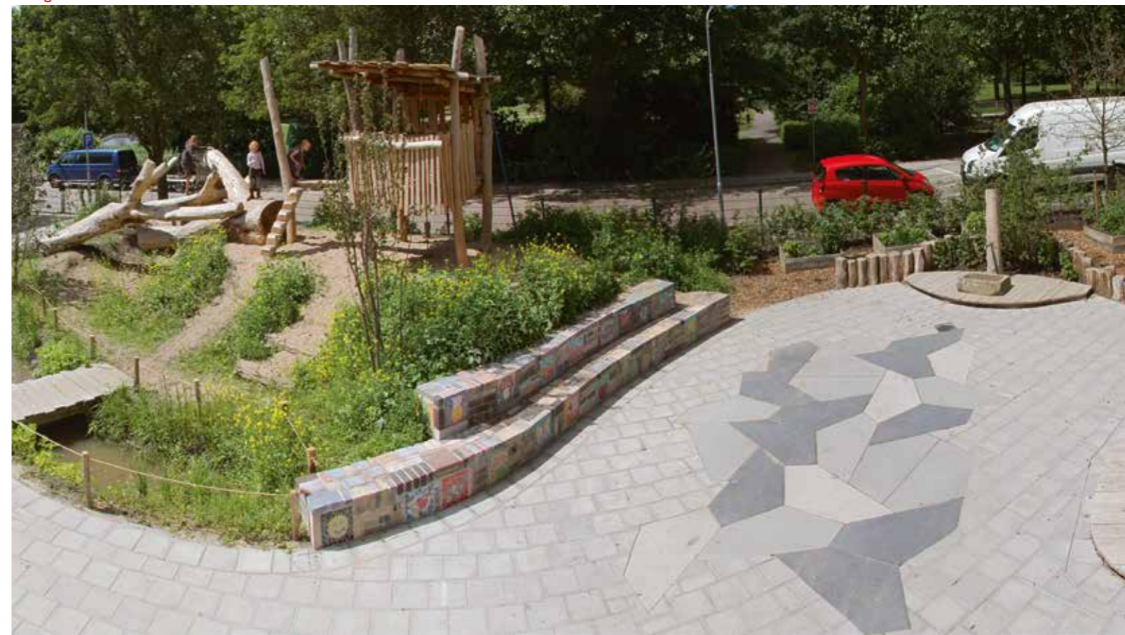
Zicht op de heuvel met klimbomen, boomhut en Prunus sargentii 'Charles Sargent', de daarnaast gelegen moestuin met waterpomp, de zitmuren van de buitenklas en de waterdoorlatende parkstenen. Alle (her)gebruikte materialen zijn duurzaam. Het hout is van eik of robinia. De houtsnippers zijn gedroogde naaldhoutchips zonder schors, de zitmuurtjes zijn gemaakt van restpartijen stenen.
