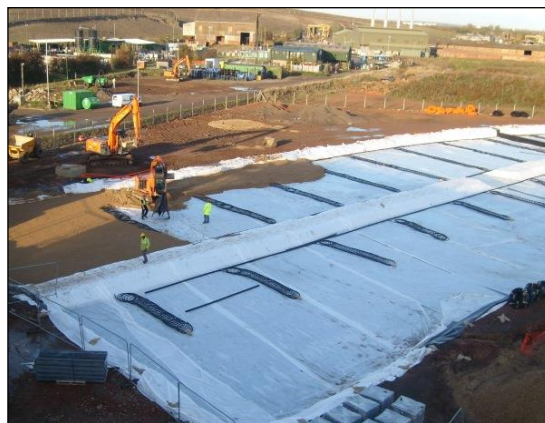
De grondcollector levert 580 kW warmte en 200 kW koude voor een kantoor met 1200 medewerkers
