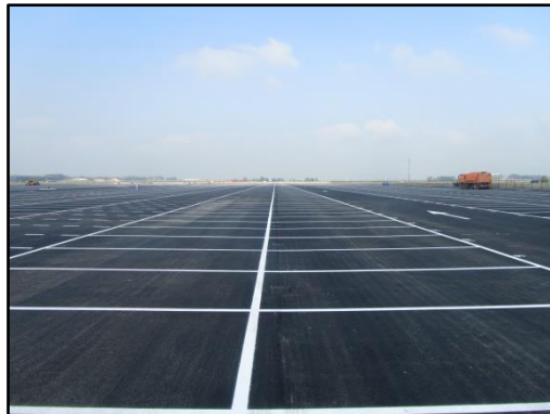
Toenemende schaalgrootte: 70.000 m2 asfalt terrein voert met WT kolken af op 20.000 m2 Aquaflow
