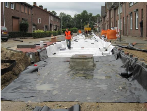
DLF folie onderin het cunet om verweking van het weglichaam te voorkomen
