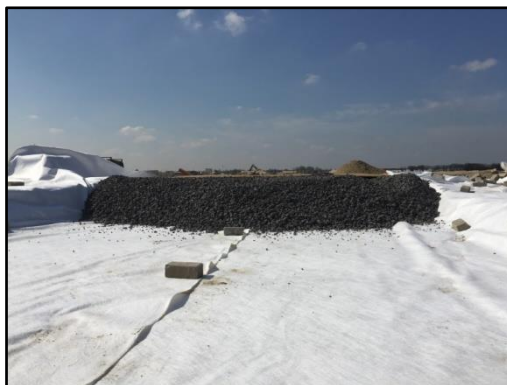
Klassieke opbouw van het aquaflowssysteem met waterpasserende verharding, vlijlaag, olieverbinder, filterdoek en waterbergende aquaflow fundering.
