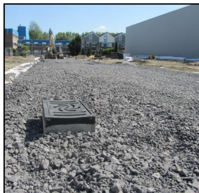
In 2001 alleen afvoer met waterpasserende stenen Nu kiest men vaak voor WT kolken
