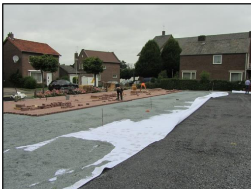
Klassieke opbouw van het aquaflowssysteem met waterpasserende verharding, vlijlaag, olieverbinderend filterdoek en waterbergende aquaflow fundering.
