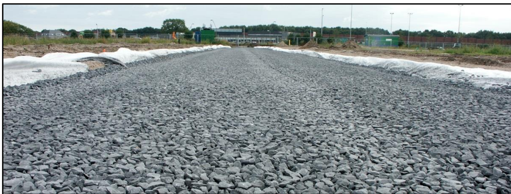
Aquaflow: waterbergend cunet, inclusief aansluitingen voor WT kolken en daken van woningen.
