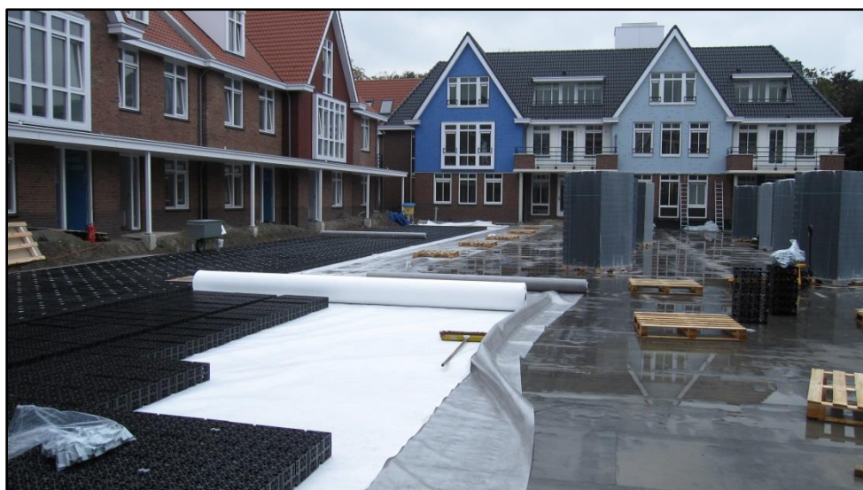
Aanleg Dakwater – waterberging op parkeergarage in Oostvoorne
