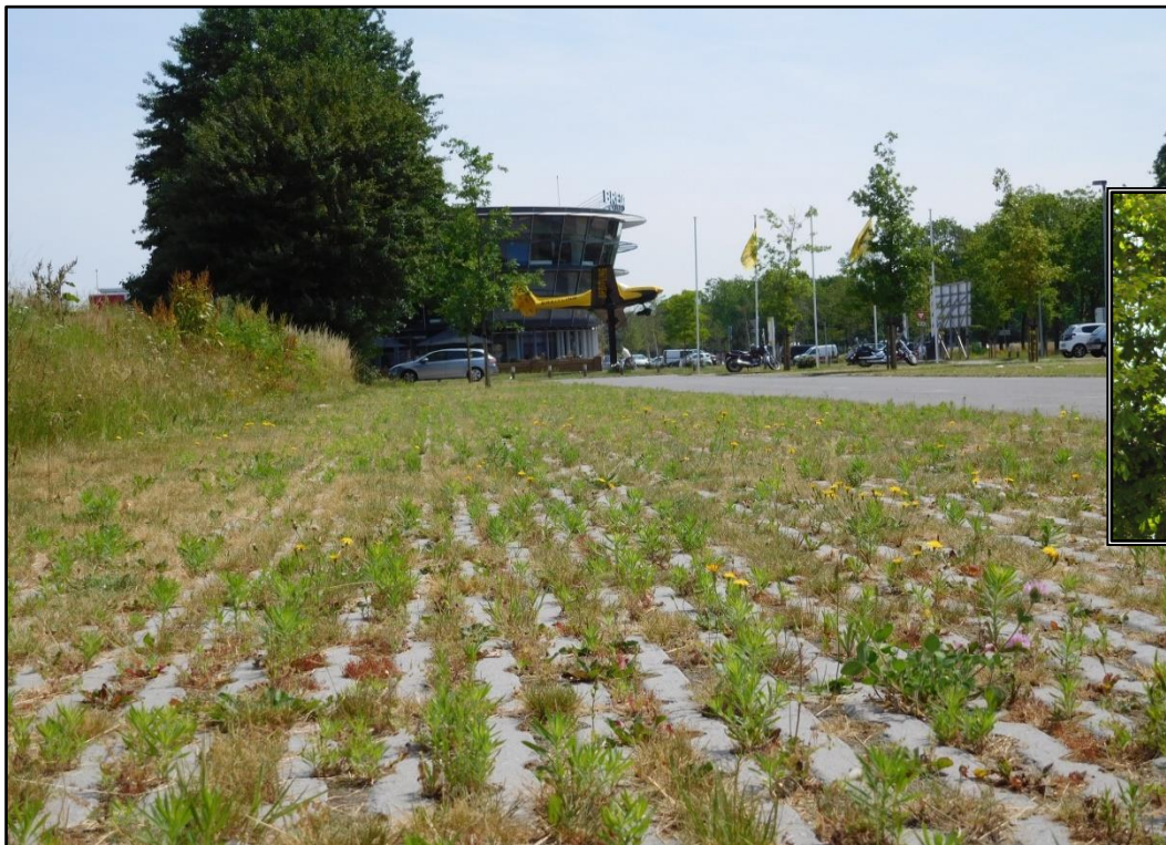
Breda Airport is beschermd gebied. Parkeren op grastegels met daaronder olieverwerkend filterdoek PF90
