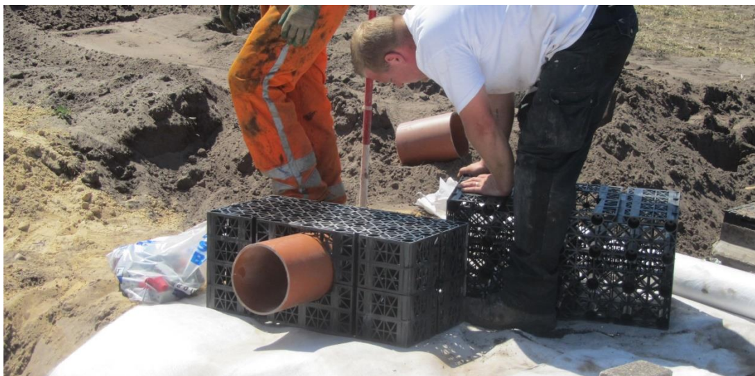
Samenstelling van aansluitstuk voor grotere diameter
