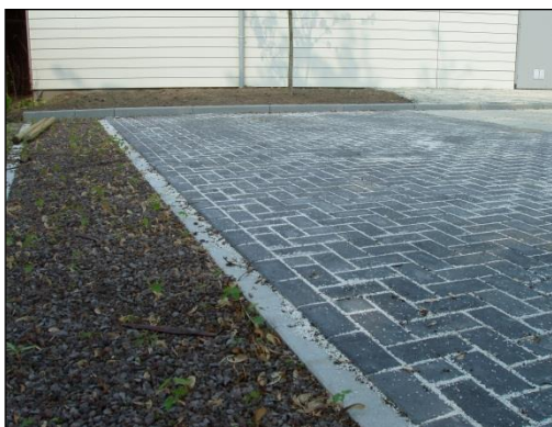
Het water kan ook wegzakken achter de parkeervakken. Dit geeft extra zekerheid
