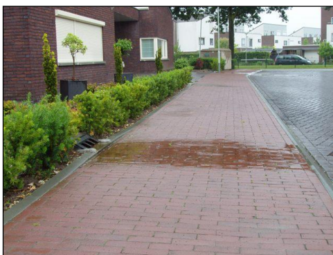
Het water loopt via het trottoir naar Aquaflow (straatkolk of trottoirkolk)
