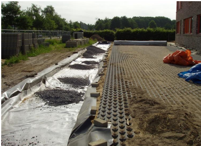
Hemelwaterbuffer in aanleg. Rechts: geurloos en transparant regenwater voor toiletspoeling
