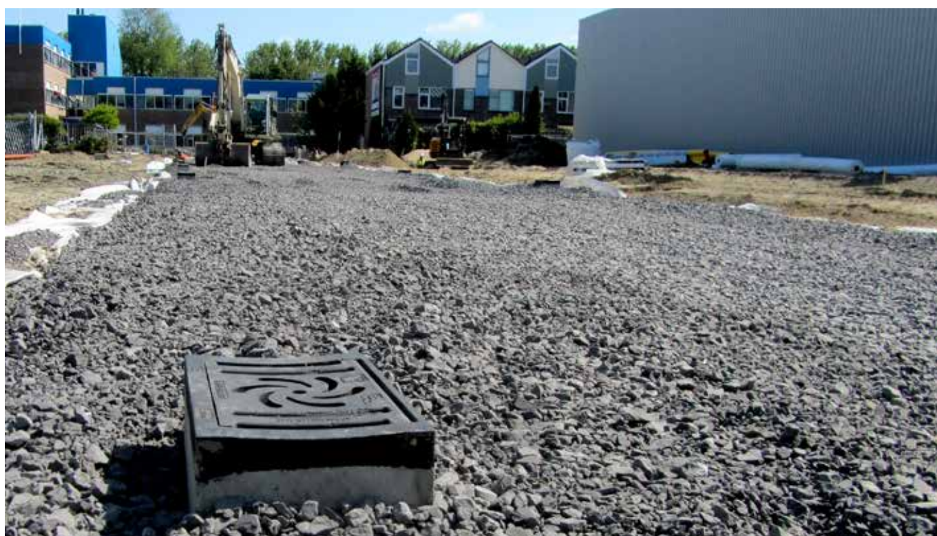
Dankzij een WT-kolk wordt hemelwater snel afgevoerd naar de waterbergende fundering.
