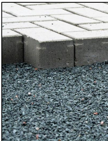
straatwerk op split
