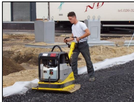
Door de hardheid (LA < 20) blijft het % holle ruimte intact
