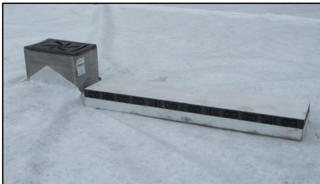
Kolk met water behandelende WT bezinkunit en zeefscherm.
