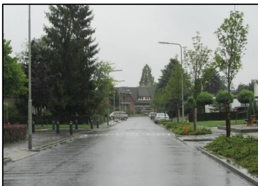
Onder elke m 2 verharding bevindt zich 140 liter berging. Afvoer hemelwater met WT kolken.
