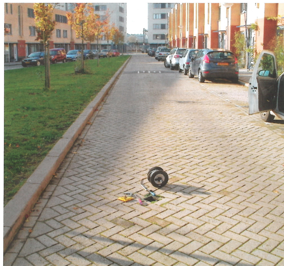
Waterpasserende verharding in Delft, met meetpunt.
