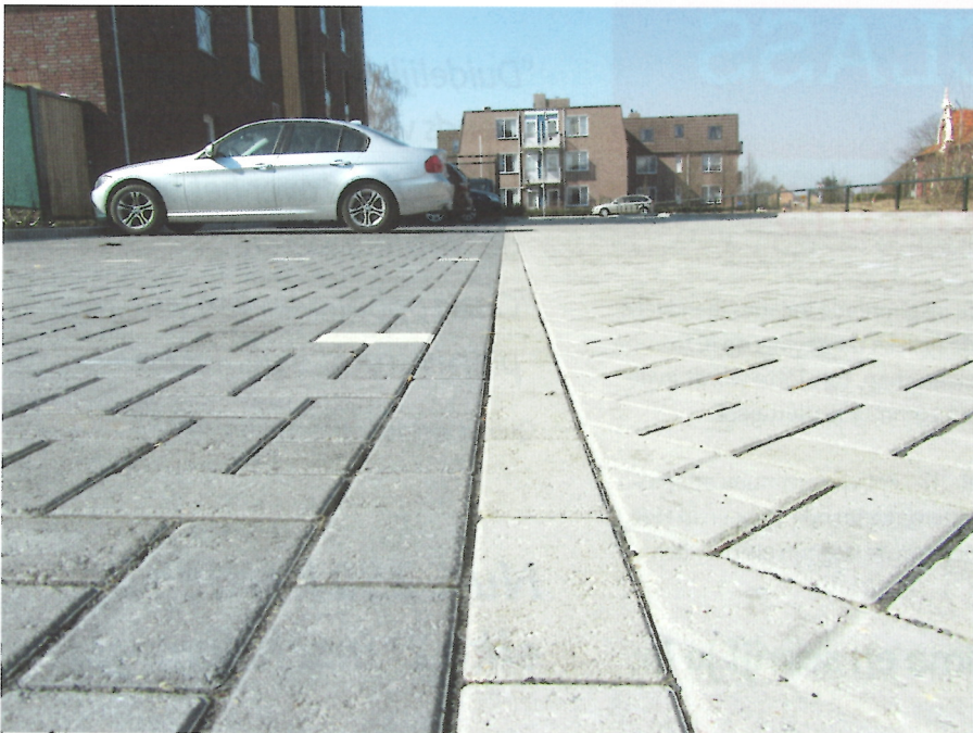
Voorbeeld van een bestrating zonder waterafvoergoot
