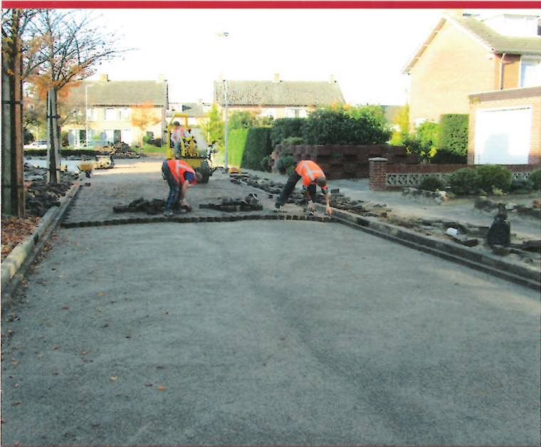
Aanleg van onderhoudsvrij Aquaflow met oude gebakken klinkers
