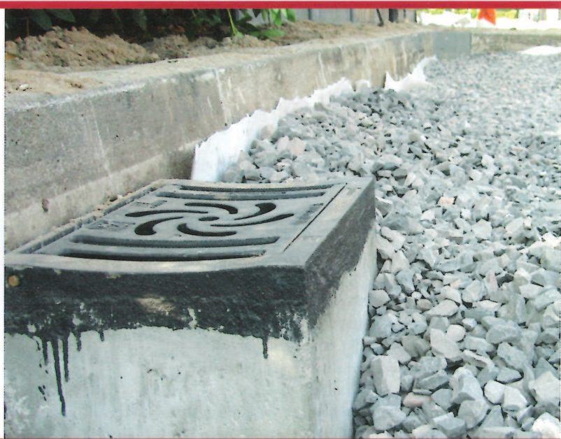
Hemelwater gaat met een aangepaste kolk naar de waterbergende wegfundering
