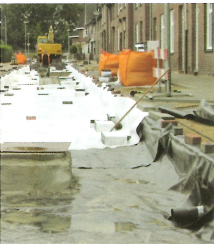
Afbeelding 3: In Schinnen worden alle kolken en hemelwaterafvoeren van de woningen direct op de water- bergende fundering aangesloten.
