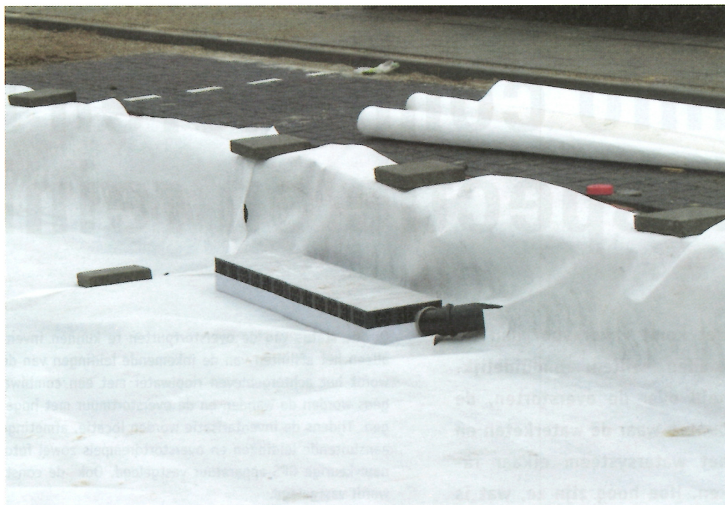
Afbeelding 5: Door de lengte van de bezinkunit wordt de stroomsnelheid sterk gereduceerd en wordt zwevend vuil afgevangen.
