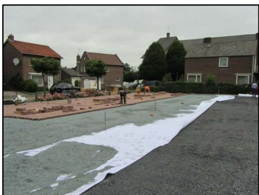
Klassieke opbouw van het aquaflowssysteem met waterpasserende verharding, vlijlaag, olieverwerkend filterdoek en waterbergende aquaflow fundering.
