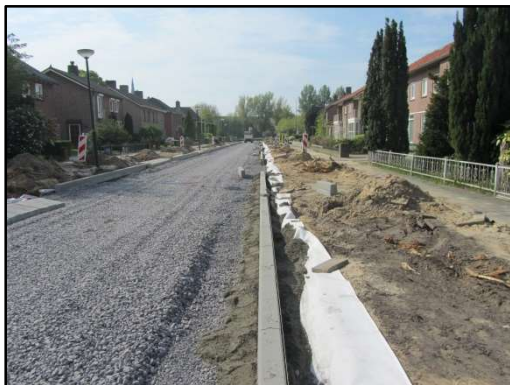
Woonstraat als waterbergende weg, tijdens aanleg en na voltooiing. Waterbuffer: 140 liter/m 2
