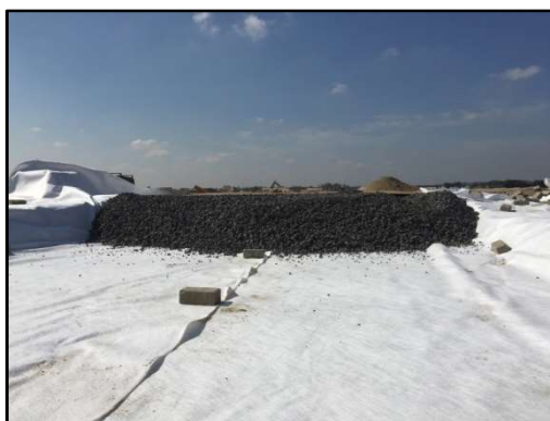
Klassieke opbouw van het aquaflowssysteem met waterpasserende verharding, vlijlaag, olieverwerkend filterdoek en waterbergende aquaflow fundering.
