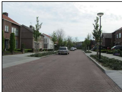
Woonstraat als waterbergende weg, tijdens aanleg en na voltooiing. Waterbuffer: 140 liter/m 2
