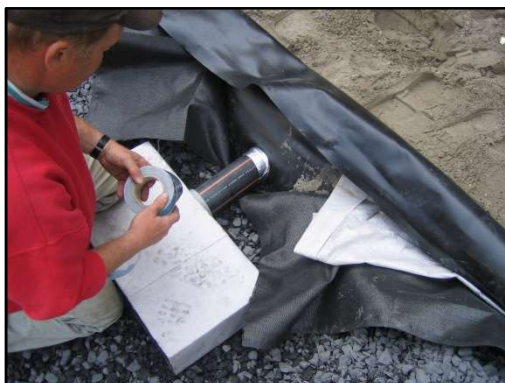
Huisaansluiting met permavoid aansluitstuk voor de overgang buis naar steenslag
