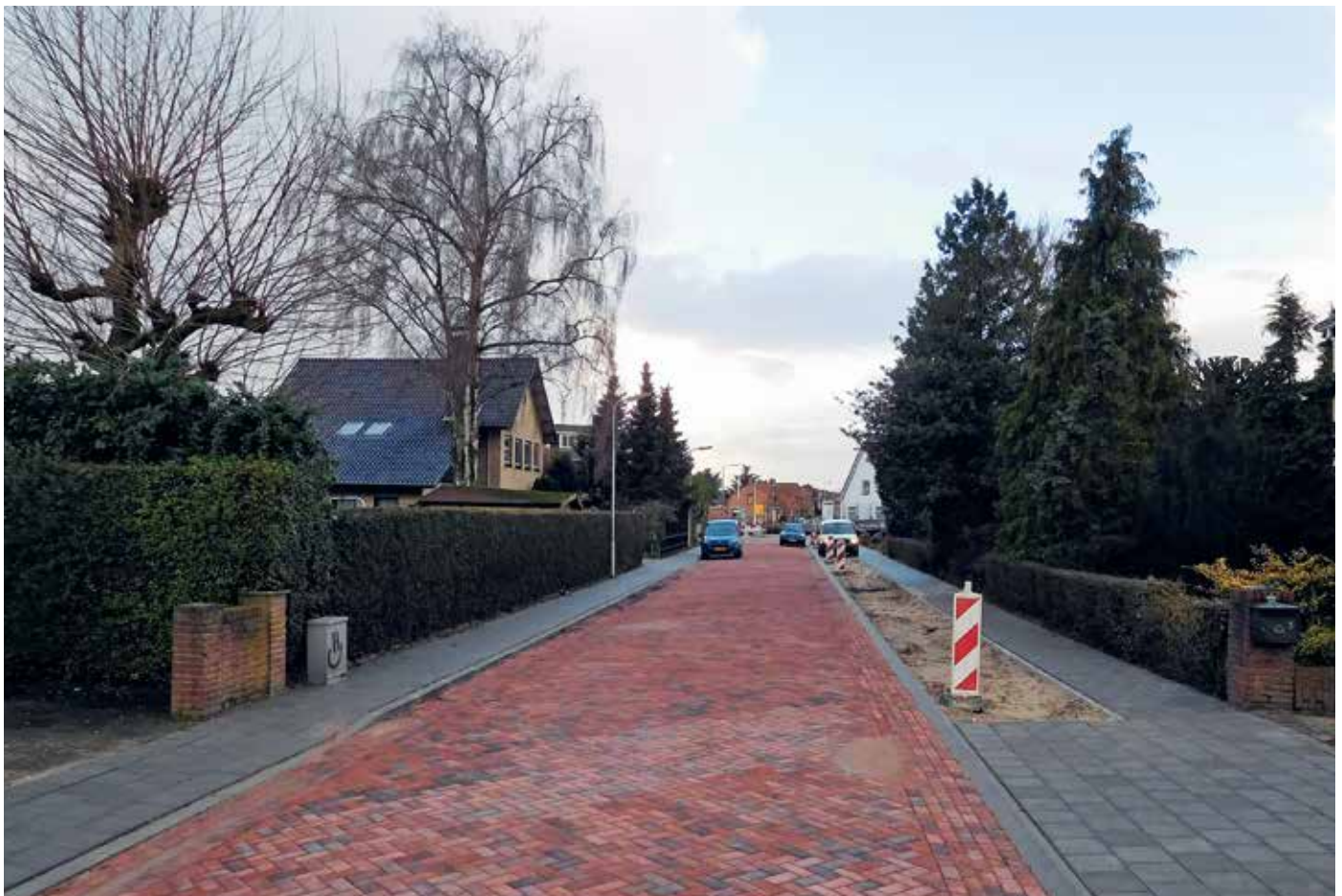
Straatwerk ingeveegd met flowsand voorkomt verdroging van steden.
