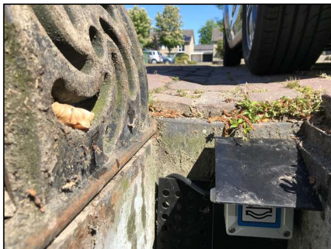
Flowfacts module gemonteerd op zeefscherm in WT kolk
