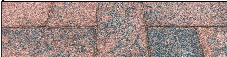
Flowsand tussen de straatstenen trekt van elke bui wat water de bodem in
