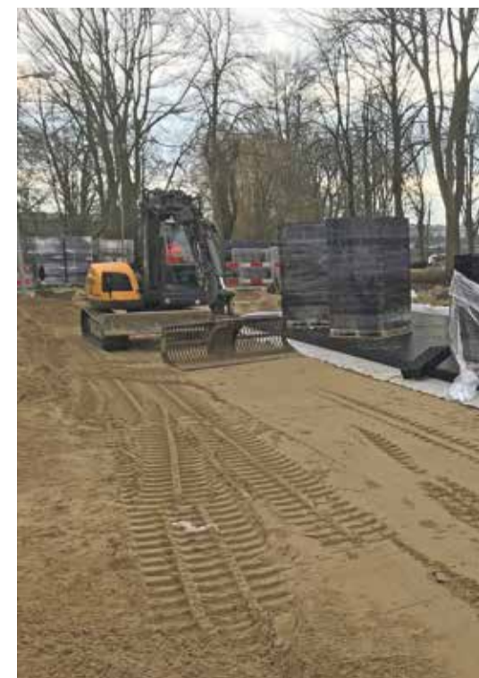
Aanleg van circa 3 meter brede strook Permavoid units
