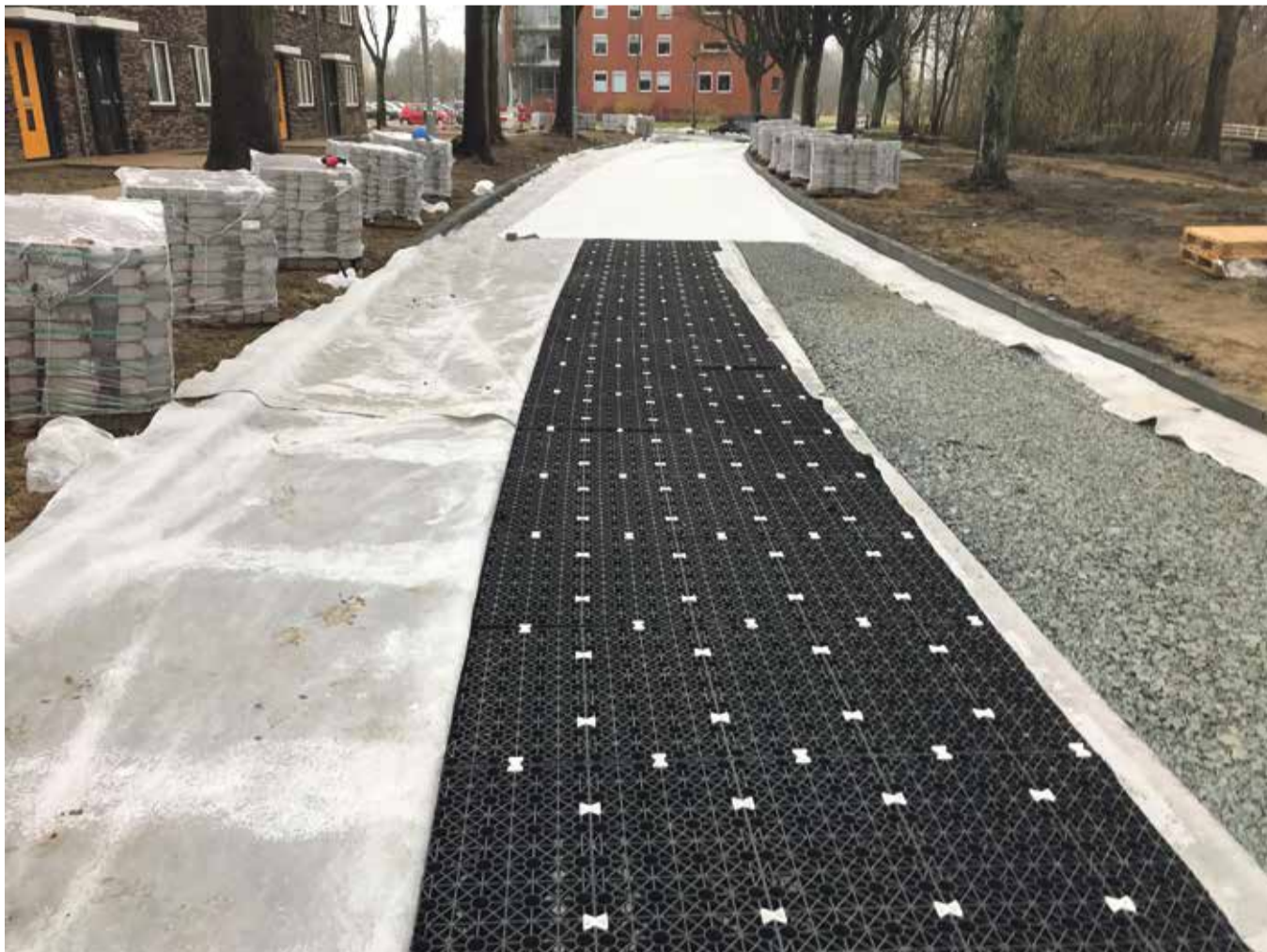
Aanleg units in Coornhertstraat.
