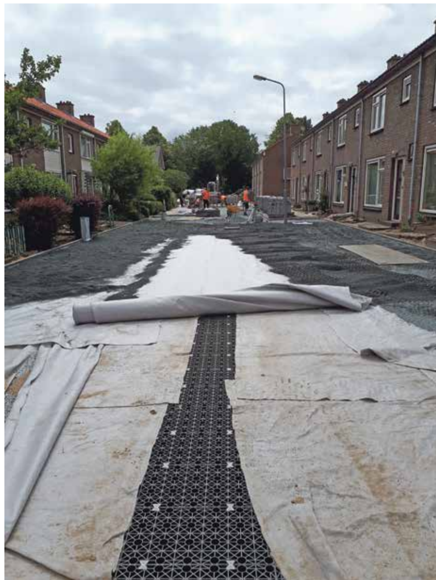
Zicht op Permavoid units, scheidingsdoek en vlijlaag van 50 mm breuksteen 2/6mm.
