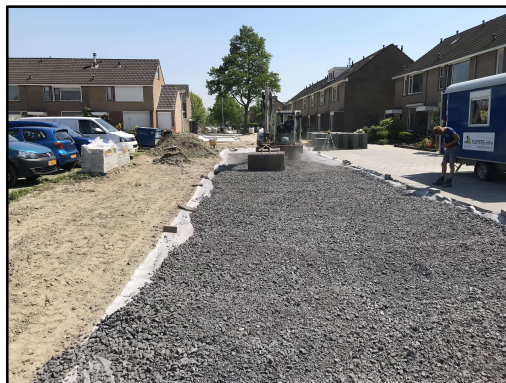
Normale neerslag: creëer voldoende afvoer- en bufferruimte, o.a. door toepassing van het Aquaflow systeem
