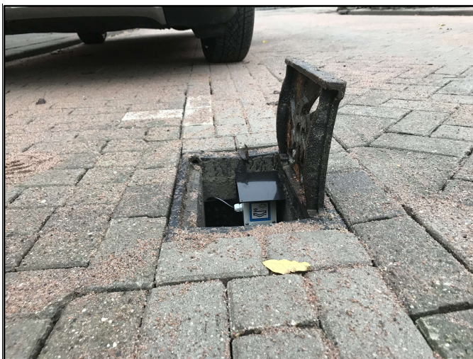
Flowfacts module gemonteerd op zeefscherm in WT kolk
