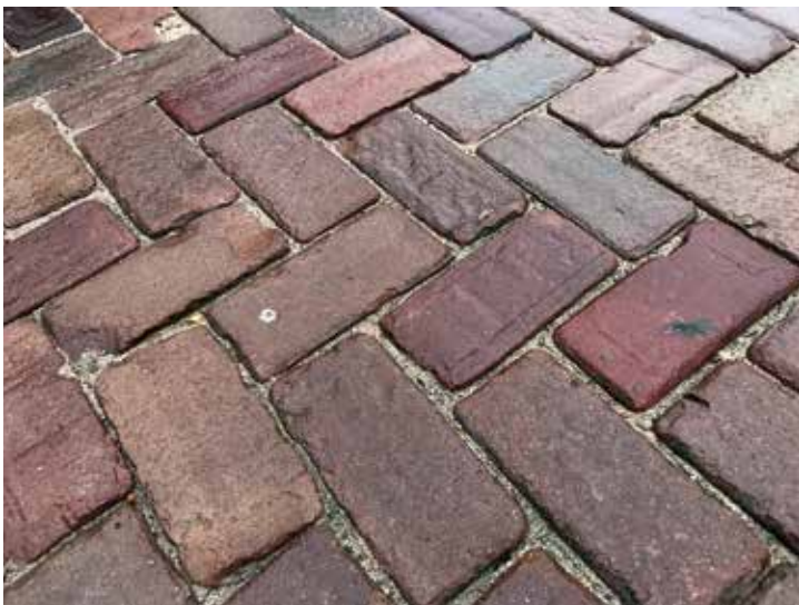
Straatwerk geperforeerd met Flowsand laat 50% van het hemelwater wegzakken
