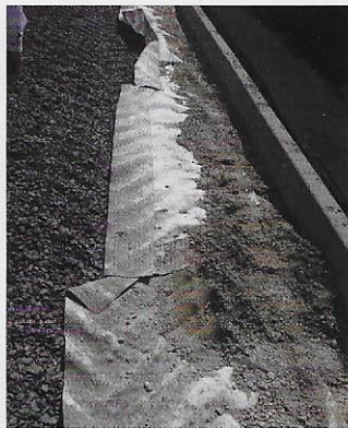
Waterbergende fundering en filterdoek
