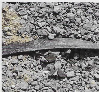
Waterbergende fundering met compartimentering (folie)
