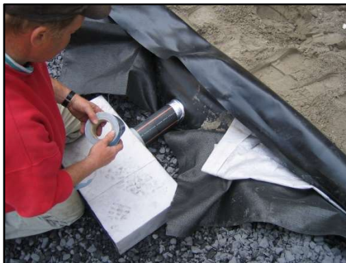
Huisaansluiting met permavoid aansluitstuk voor de overgang buis naar steenslag
