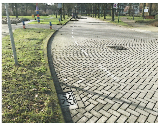
Oude vervuilde infiltratiebestratingen kunnen eenvoudig worden omgebouwd naar waterafvoer met WT kolken
