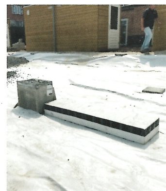
De WT bezinkunit aan de kolk heeft een overstortwand van 350 cm
