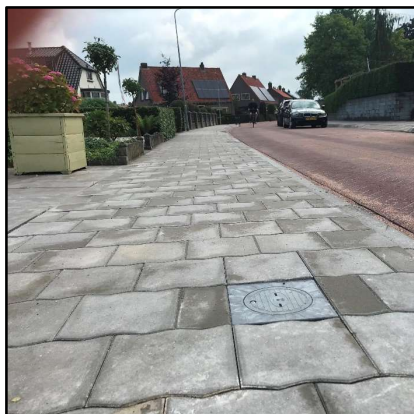
Flowfacts wordt in een putje geplaatst en verbonden met de waterbergende weg.
