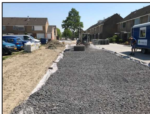
Normale neerslag: creëer voldoende afvoer- en bufferruimte, o.a. door toepassing van het Aquaflow systeem
