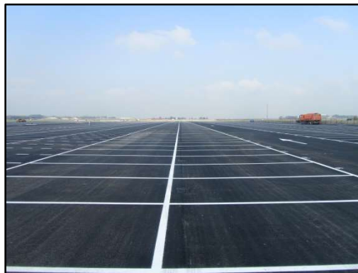
Toenemende schaalgrootte: 70.000 m 2 asfalt met WT kolken wordt gebufferd in 20.000 m 2 Aquaflow
