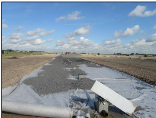
Toenemende schaalgrootte: 70.000 m 2 asfalt met WT kolken wordt gebufferd in 20.000 m 2 Aquaflow
