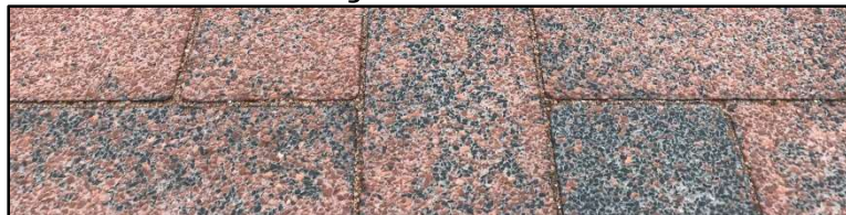
Flowsand brengt hemelwater in de bodem op de plaats waar het valt
