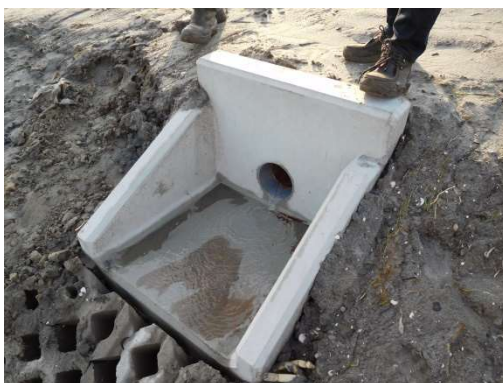
De vertraagde afvoer loopt uit in een uitstroombak
