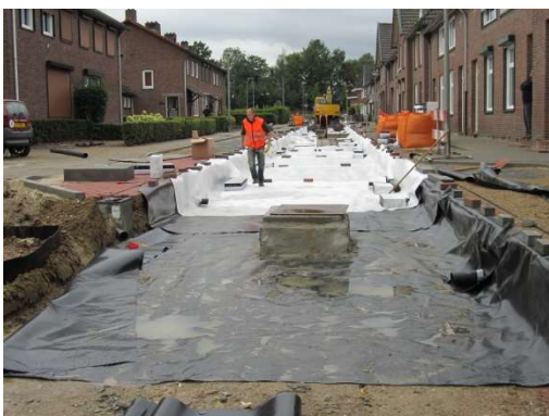
DLF folie onderin het cunet om verweking van het weglichaam te voorkomen
