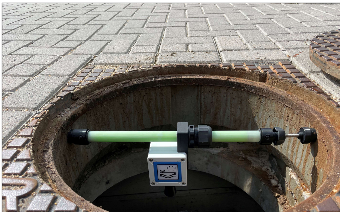
Contactloos meten in een debietbeperkingsput in een Aquaflowsysteem.
