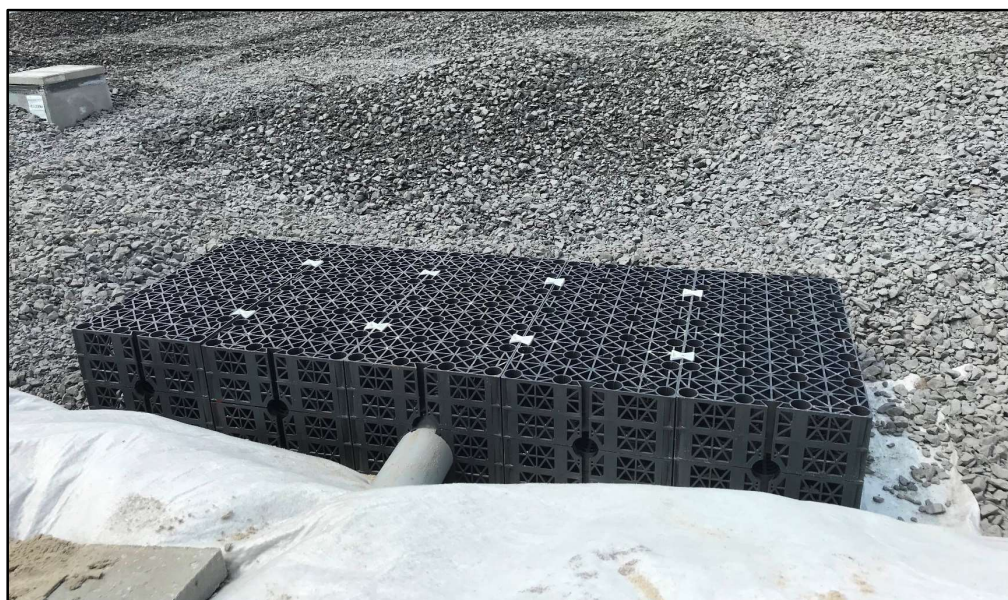
Samenstelling van aansluitstuk XL voor grotere hwa leidingen (hier 160mm met 10 units)
