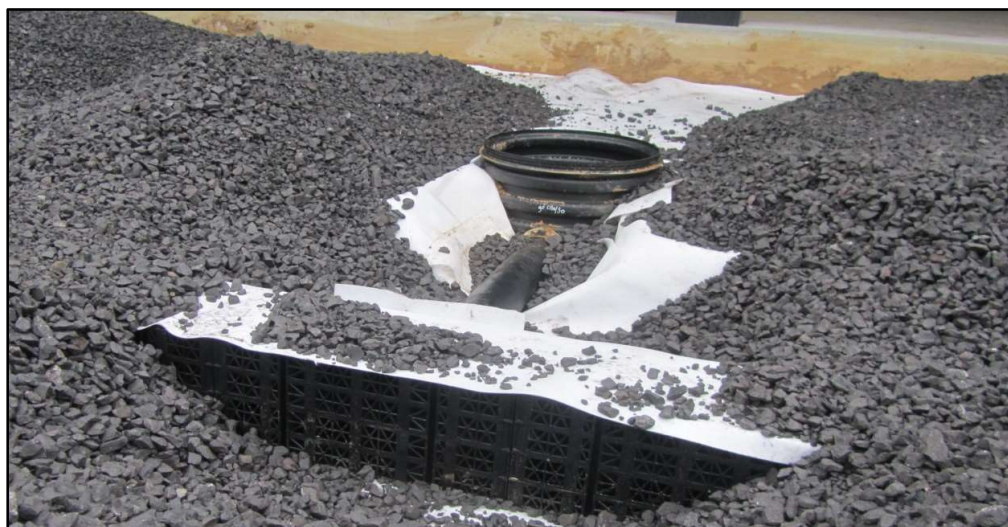
Voor het aansluitstuk XL zit een hevel- / stijg- / inspectieput
